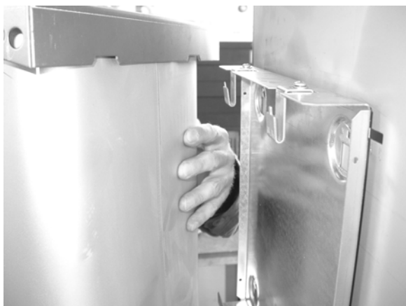
Abbildung 9: Montage des Öltanks
